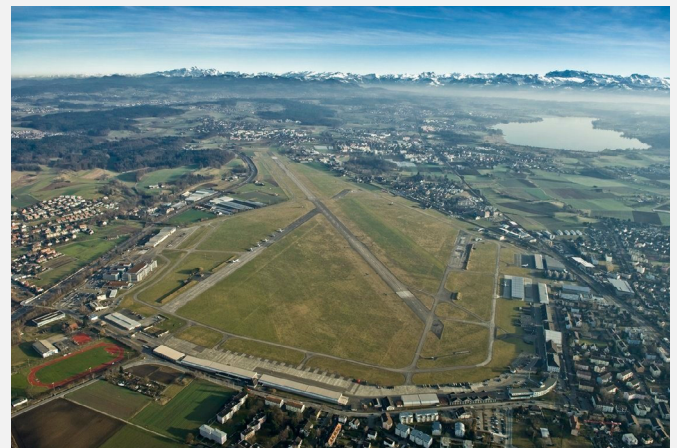
Abbildung 1: Die 2,8 km lange Piste des Militärflugplatzes in Dübendorf, Kanton Zürich
